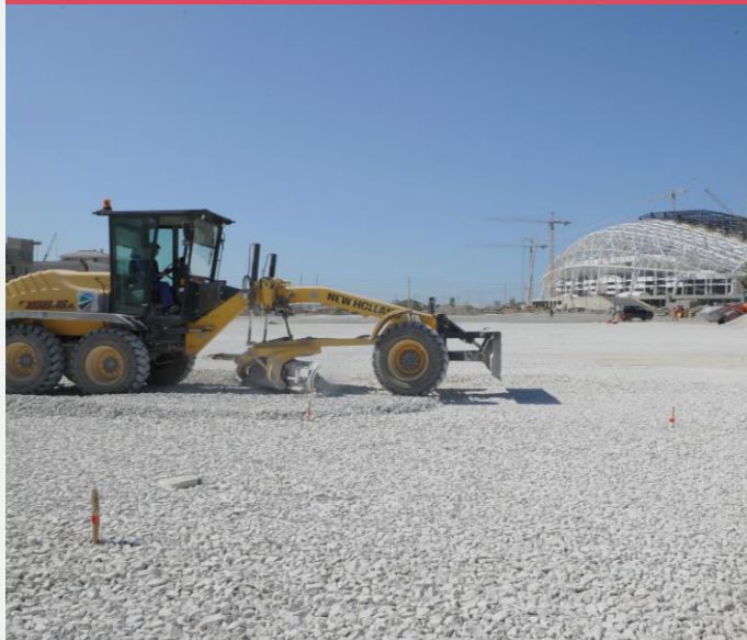
Строительство совмещенной (автомобильной и железной) дороги Адлер— горноклиматический курорт «Альпика-Сервис», а также объектов Олимпийского парка
